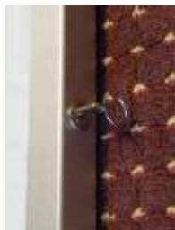
Star: Schloss seitlich im Rahmenprofil, von vorn nicht sichtbar
